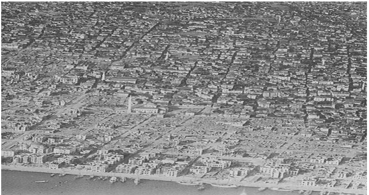
Αεροφωτογραφία της περιοχής μετά την καταστροφή
